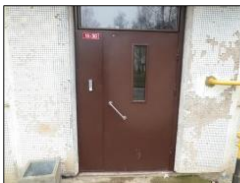
Kāpņu telpas ārdurvis
